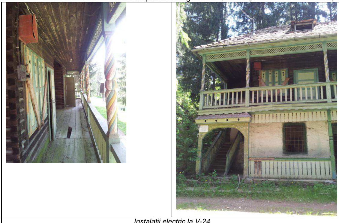
Instalații electric la V-24
